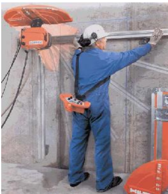
Σχ 2: Κοπή τοίχου με δισκοπρίονο επί τροχίων καθοδήγησης
